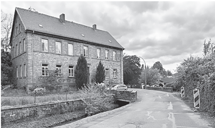
Pläne der Maßnahme sowie der Umleitungsstrecke können Sie auf www.bessenbach.de einsehen.
