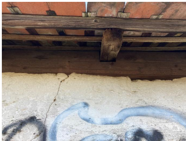
Abb. 8: Walmdach der Alten Kelter, Dachtrauf
