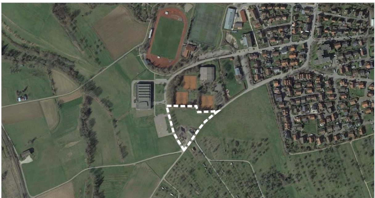
Abb. 6: Bestandssituation, Luftbild (Quelle: Google Earth)
