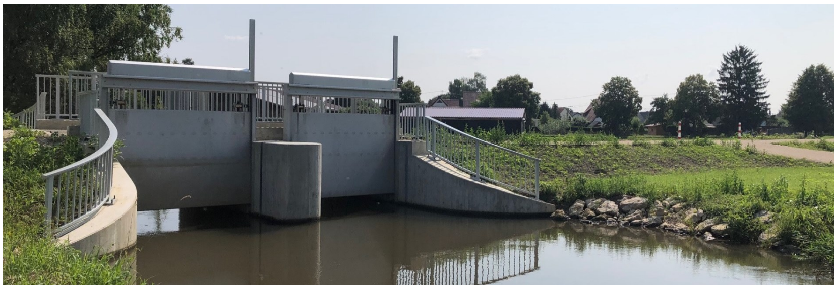
Der Hochwasserschutz ist offiziell fertiggestellt.
