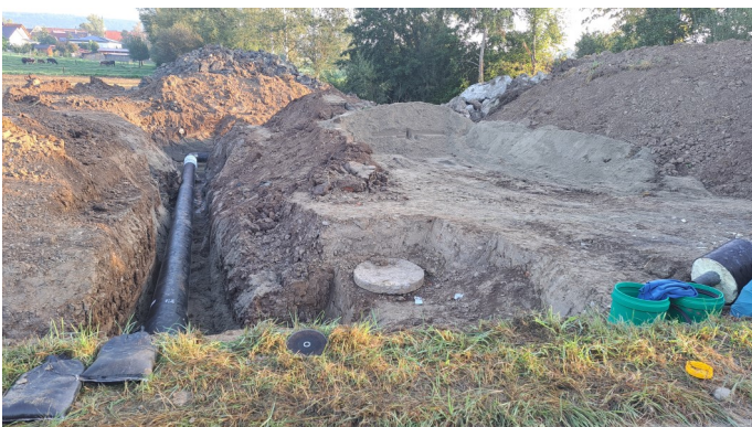
Querung Soppenbach/Mühlbach mit Wärmeleitung
