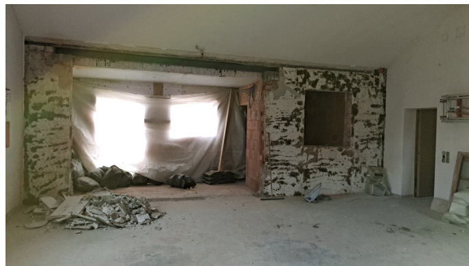
Feuerwegerätehaus Heiligkreuztal, Abbrucharbeiten
