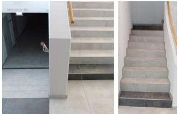
Die bisherigen Treppenauf- und -abgänge (Bilder links) wurden durch farbliche Absetzungen für sehbehinderte Menschen leichter begehbar gemacht. Der Bodenbelag in den Foyers hatte ausgedient. Durch das neue Pflaster wurde so Abhilfe geschaffen.
