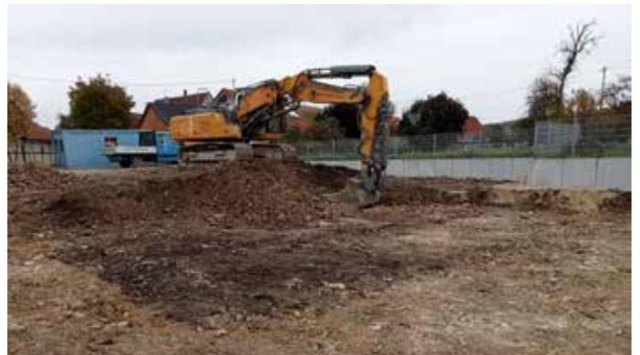
Zuerst wird eine Planie hergestellt, dann erfolgt der Aushub und die Baugrube für die Löschwasserzisterne.
