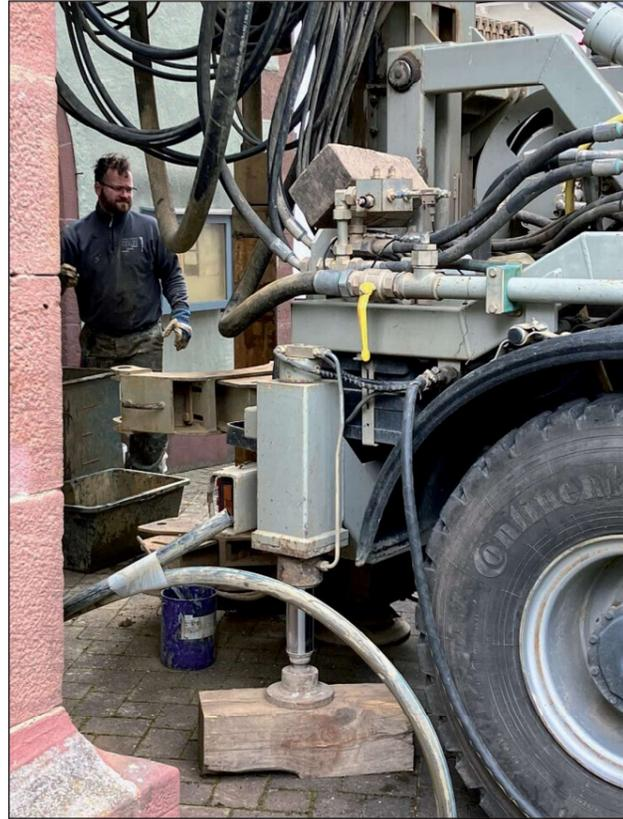
**Sanierungsfall:** Der Turm der evangelischen Kirche aus dem 15. Jahrhundert neigt sich langsam bedenklich zur Seite – um genau 46 Zentimeter. Er muss aufwändig stabilisiert werden.
