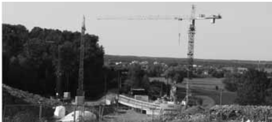
S-Bahn-Brücke mit künftiger Straßenunterführung B 464
