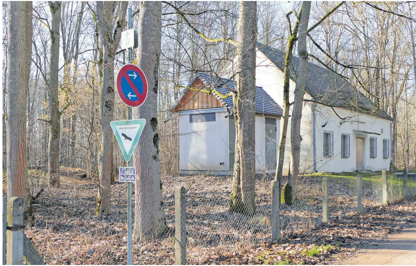
Das Wasserwerk Donau wurde 1963 in Betrieb genommen, muss aber trotz regelmäßiger Instandhaltungsmaßnahmen, nun generalsaniert werden, um zukunftsfähig zu bleiben.
