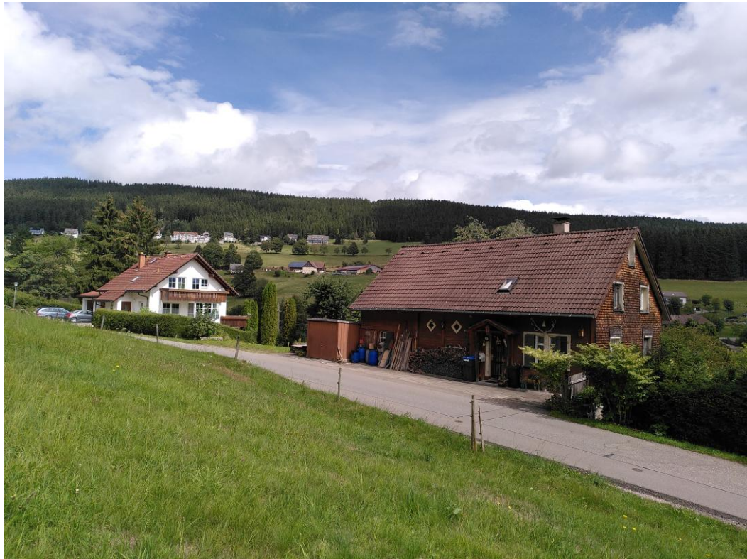
Abb. 4: Angrenzende Bebauung. (Foto: bhm)
