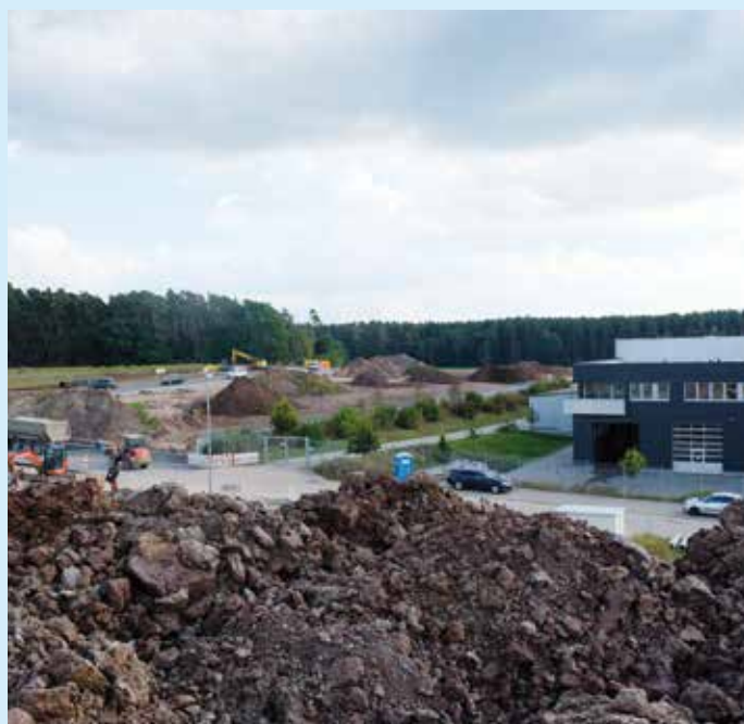
Im Gewerbegebiet-Süd werden die Erschließungsmaßnahmen der Gemeinde durchgeführt
