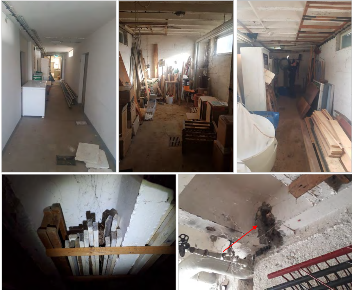
Abbildung 3: Beispielhafte Bilder der tageslichtdurchfluteten Räume im Untergeschoss (obere Bilder). Insgesamt wurden nur wenige potenzielle Quartiere gefunden. Hinter lagernden Materialien ergeben sich abgedunkelte Nischen und Spalten, welche für Fledermäuse potenziell Hangplätze darstellen (unten links). In einem der Geräteräume ist das Mauerwerk beschädigt, wodurch Tiere rein und raus wandern können. Zahlreiche Spinnweben, lassen jedoch auf keine regelmäßige Nutzung schließen (unten rechts). (Fotos: Manuel Schulz, 17.03.2023)
