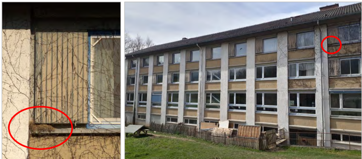
Abbildung 7: Die Ostseite des Wohnheimgebäudes Haus 8 weist zahlreiche potenzielle Quartier- sowie Nistmöglichkeiten für Fledermäuse und Vögel hinter den Fensterläden sowie in und hinter den Rollladenkästen auf. Vom Haussperling konnte hier nur ein Nest am obersten rechten Fenster auf einer Fensterbank erfasst werden (Bild oben links). (Fotos: Manuel Schulz, 05.06.2023 (links), 17.03.2023 (rechts))
