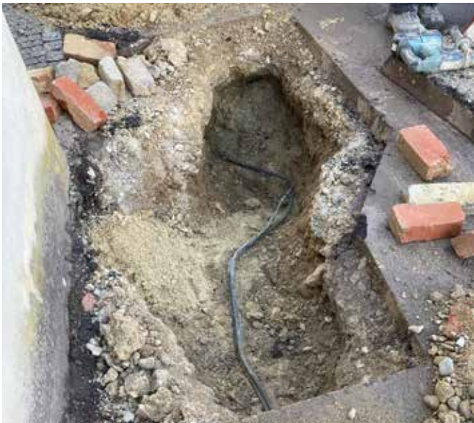
Fehlersuche beim Gehweg an der Kirche.
