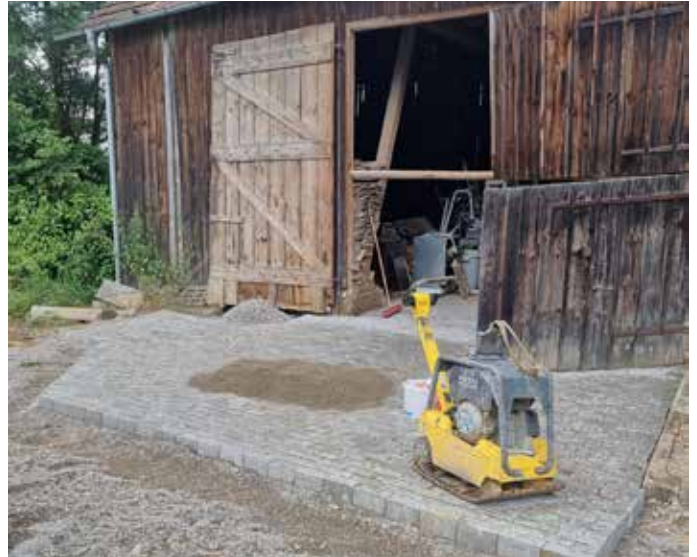
Pflasterarbeiten am oberen Gemeindeschuppen.
