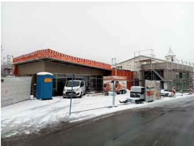
Auch die Fassadenarbeiten stehen vor dem Abschluss, so dass noch vor den Feiertagen das Gerüst abgebaut werden kann.
