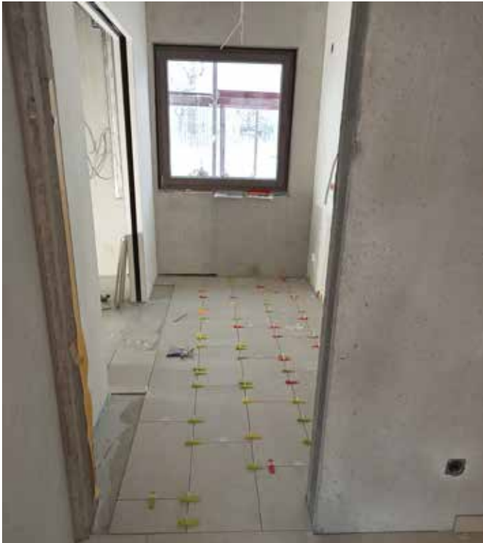
Der Fliesenleger ist hier in der Teeküche bei den letzten Arbeiten.
