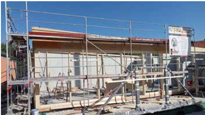
Die Pfosten-/Riegelfassade wurde aufgestellt. Die komplette Verglasung verbindet den Dorfplatz mit dem Dorfgemeinschaftsraum.
