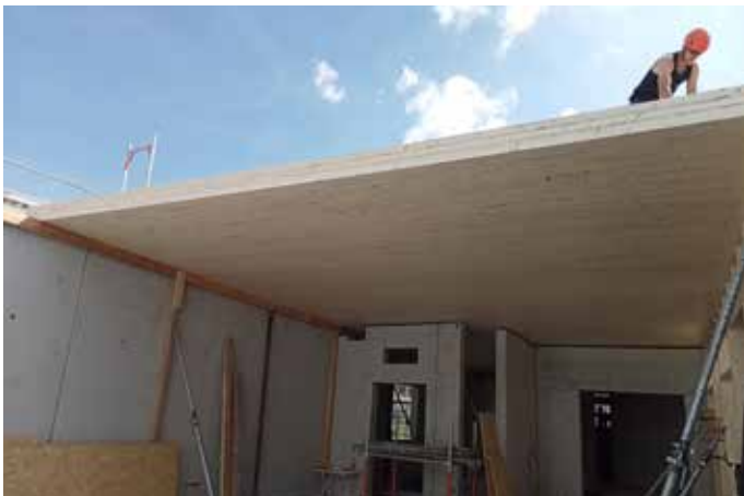
In massiver Fichte Brettbauweise wurde das Dach über dem Dorfgemeinschaftsraum aufgebaut.
