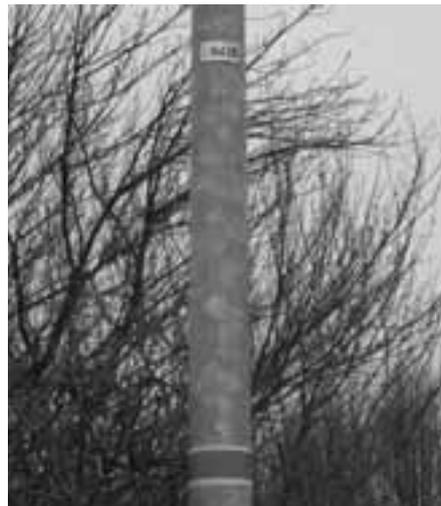
Ebenfalls wurden bei den Nummerierungsarbeiten alle Beleuchtungsmasten, die im reduzierten Betrieb abgeschaltet werden, mit einem rot-weißen Markierungsband versehen. Im ganzen Ortsgebiet verteilt gibt es noch ca. 60 Straßenlampen die nur halbnächtlich betrieben werden. Diese Straßenleuchten brennen abends nur bis 23.00 Uhr. Morgens werden sie von Montag-Freitag ab 5.30 Uhr wieder eingeschaltet, an Samstagen ab 7.00 Uhr und an Sonn- und Feiertagen bleiben sie morgens außer Betrieb.
