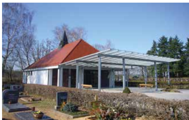
Aussegnungshalle am städt. Friedhof, in der das neue WC eingebaut wird.
