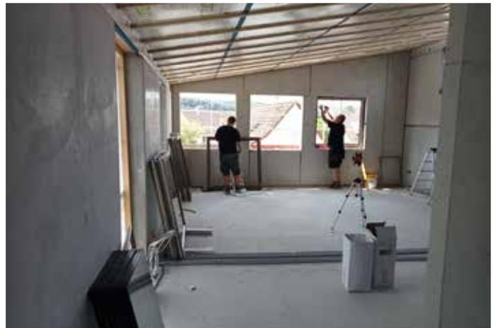
Die Fensterbauer der Firma Stocker aus Uttenweiler bei der Montage im Schulungsraum der Feuerwehr. Alle Holzfenster sind aus Fichtenholz mit einer grauen Lasur behandelt.
