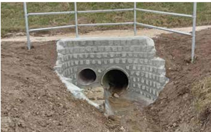
Hier der Ausfluss auf der Nordseite. Rechts die alte Röhre die auf zwei Drittel der Strecke auf 80 Zentimeter reduziert wurde, links die neue zusätzliche Röhre. Die ganze Anlage ist nun durch ein Schutzgitter gegen Absturz gesichert.
