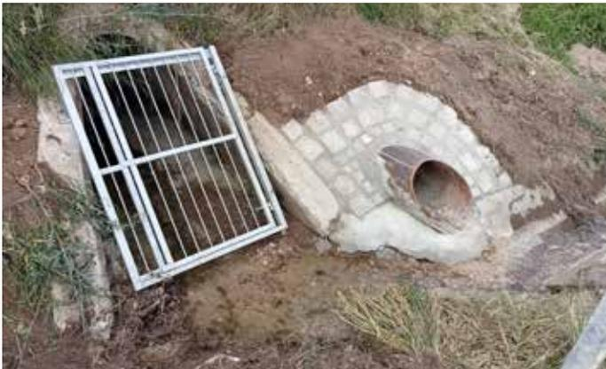
Die Einlaufseite von Süden her. Links der alte Durchfluss in einer Höhe am Einlauf mit 150 Zentimeter, mit dem Schutzgitter. Rechts die neue zusätzliche Stahlröhre mit 50 Zentimeter Durchmesser.
