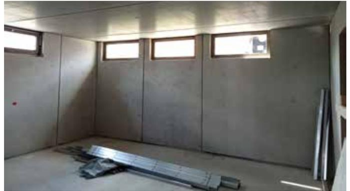
In der Umkleidekabine der Feuerwehr wurden Gläser mit UV Filter eingebaut, damit die Schutzkleidung der Feuerwehr nicht ausbleicht.
