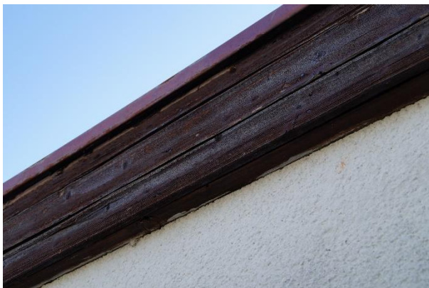
Foto 9: Doppelgarage – Attika (Blick nach Osten)
