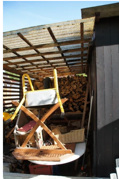
Foto 11: Unterstand/Holzlager (Blick nach Norden)
