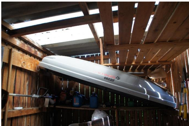
Foto 12: Schuppen – Innenansicht (Blick nach Norden)
