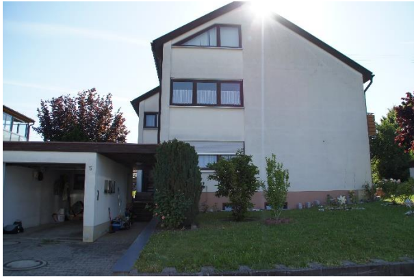
Foto 1: Wohngebäude und Doppelgarage (Blick nach Osten)
