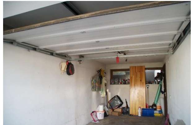
Foto 8: Doppelgarage – Innenansicht (Blick nach Osten)
