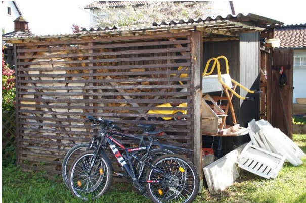
Foto 10: Schuppen mit Unterstand/Holzlager (Blick nach Osten)
