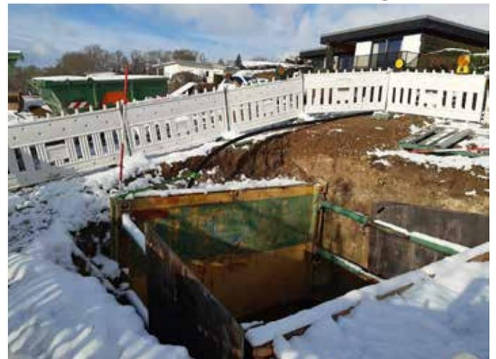
Rohrvortrieb für RW-Entlastungsleitung „Borenbrunnen Nord“.
