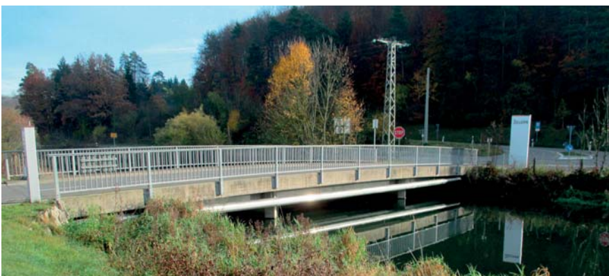
... und von Süden mit der Anbindung an die Landesstraße 455.
