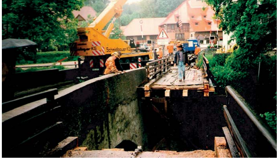
Eine Arbeitsgruppe des THW baute am 8. September 1993 mit Hilfe eines großen Krans den hölzernen Fußgängersteg ab.
