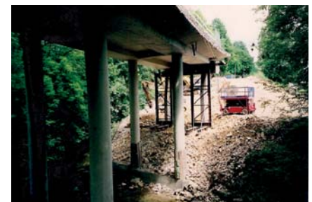
Abbrucharbeiten im Rahmen der grundlegenden Renovierung 2004.
