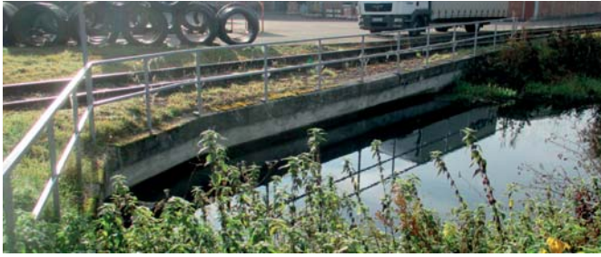
Die Eisenbahnbrücke von 1924 über den Werkskanal.
