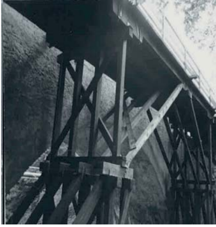
Der von Bundeswehrpionieren gebaute Fußgängersteg war oberhalb direkt an die alte gemauerte Steinbogenbrücke angelehnt. Er wurde über zwanzig Jahre lang genutzt.
