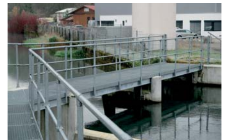
... und oberhalb des Kraftwerkes, 2017.
