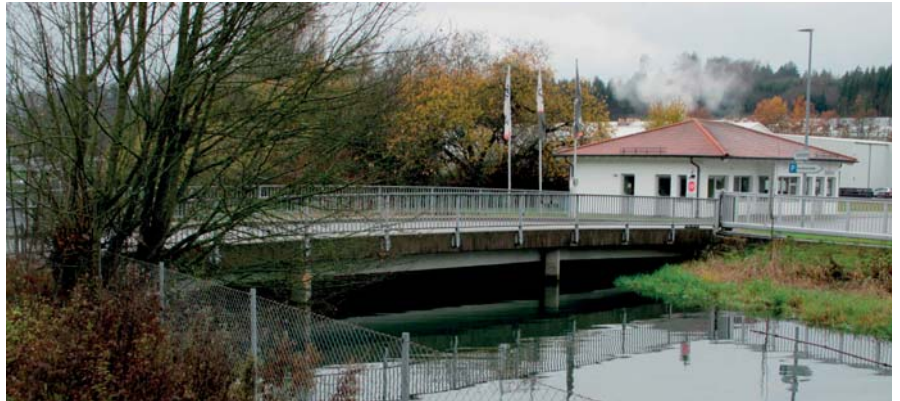
Die Osttorbrücke, von Norden her gesehen, gebaut 1997, mit dem Pförtnerhaus ist der Hauptzugang zu Zollern. Über diese Brücke erreicht der gesamte Warenein- und -ausgang per Lkw das Werk. Sie ist auch Zufahrt für einen großen Teil der Beschäftigten.
