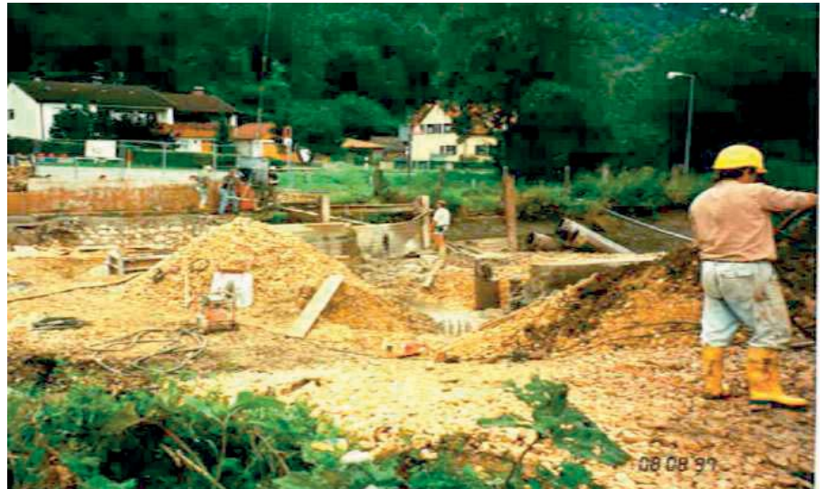
Von der Werkseite aus Richtung Hitzkofer Straße und Brixinsweg: Bauarbeiten an der neuen Osttorbrücke im Sommer 1997.
