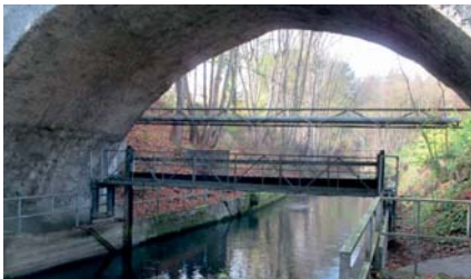
Der für eventuelle Noteinsätze der Feuerwehr gebaute Eisensteg direkt unter der Bogenbrücke. Im Hintergrund quert eine Versorgungsleitung das Flussbett.
