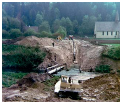
Die Verlegung der Wasserleitung durch die Lauchert 1978/79.
