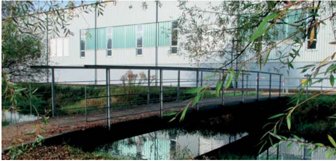
Der Fußgängersteg von 2002 über den Werkskanal.
