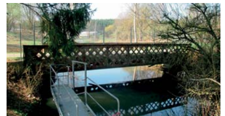
Die Brücke über den Werkskanal.
