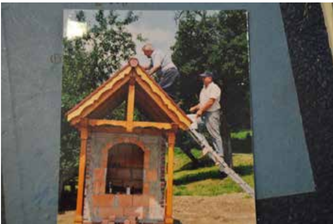
Ludwig Gräter und Waldemar Brauchle beim Bau des neuen Käppele.
