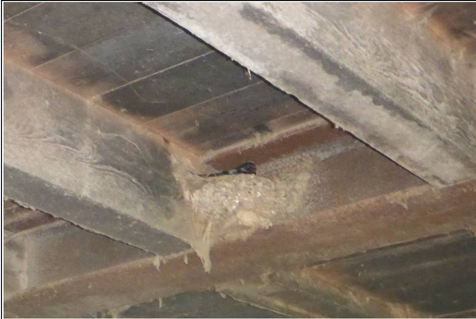
Rauchschwalben-Nest mit brütendem Altvogel an den Deckenträgern des Rinderoffenstalles.
