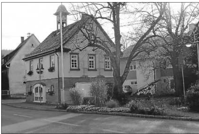
Zentral und mit Potenzial: das Heutensbacher Rathaus
