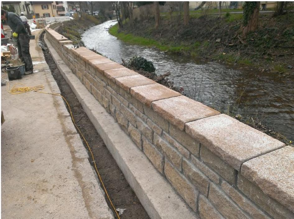
Abb. 6: Mauer aus Betonsteinen mit ähnlicher Optik wie Natursteine
