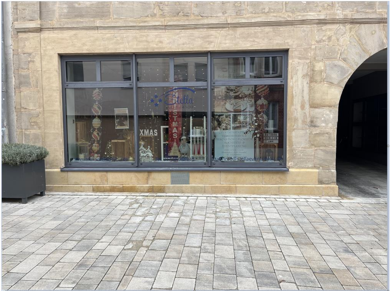
Abbildung oben: Gebäudesockel nach der Sanierung
