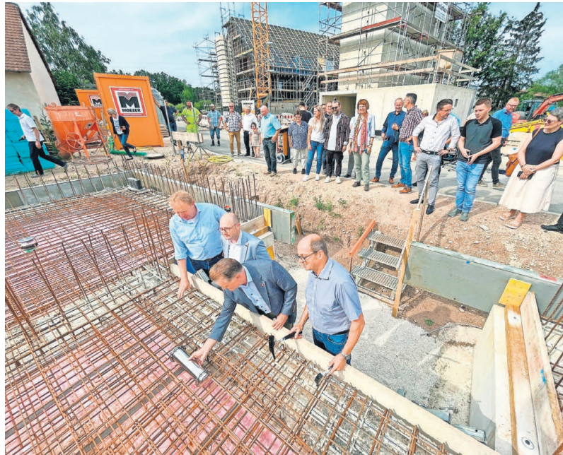
Die Grundsteinlegung: Wendelsteins Bürgermeister Werner Langhans (3.v.l.) versenkt die Kapsel mit Urkunde, Tageszeitung, Münzen, Bauplänen und Presseberichten zum Projekt in der Armierung von Haus 1. Mit dabei (v.l.) MdL Volker Bauer, Architekt Michael Zaschka und Willibald Hierl vom Technischen Baureferat der Gemeinde Wendelstein. Foto: Robert Gerner
