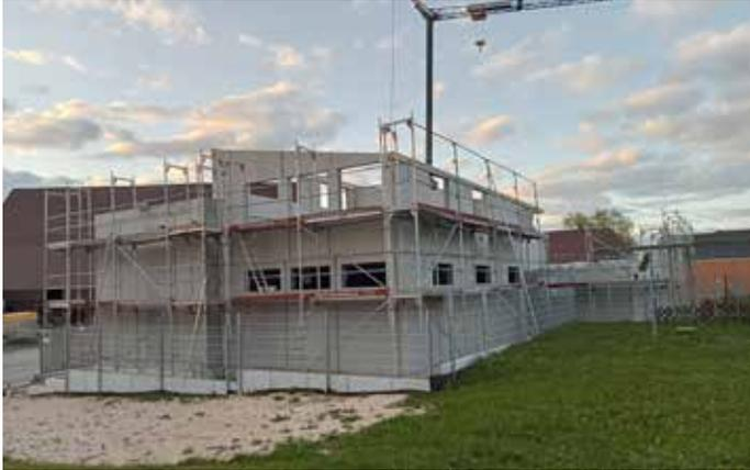
Ansicht von Südost, also hinten. Die Schwellen liegen schon auf dem Mauerwerk auf, bevor dann die Dachelemente aufgerichtet werden.
