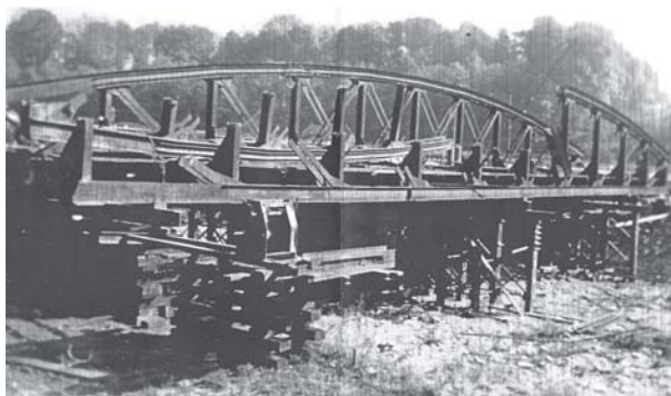
Abbau des auf Dorfer Gemarkung stehenden Teils der Eisenbahnbrücke 1957 durch die Firma Weck (links).
