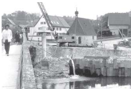
Bau der Donaubrücke 1987. Rechts eine Spundwand zur Aufnahme des rechten Pfeilerfundamentes. Links: Einbringen eines Betonpfahls zur Gründung des rechtsseitigen Widerlagers.
