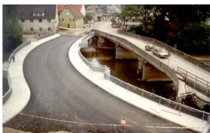
Sommer 1987: Zwei Donaubrücken. Die alte Brücke (rechts) wurde im Juli 1987 abgebrochen.
