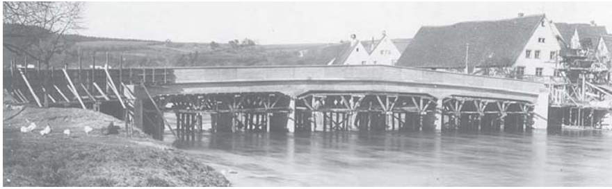
Neubau der Donaubrücke 1921/22. Rechts die Betonmischmaschine. Im Hintergrund: Sturzen und Weingarten noch völlig unbebaut
