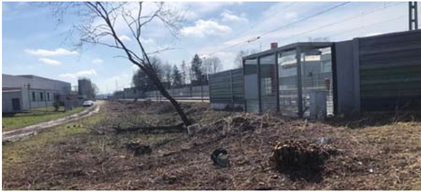
Der Bahnsteig Richtung Donauwörth könnte bald Formen annehmen.
