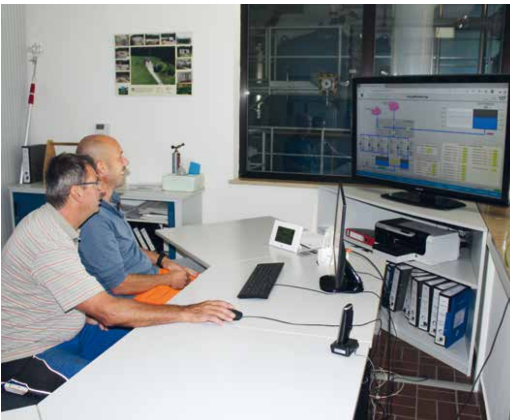
Alfred Döbel und Jürgen Jähn im Wasserwerk
