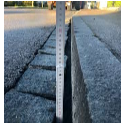
Zwei Tonnen Beton wurden für den Verguss dieser Fuge benötigt.
