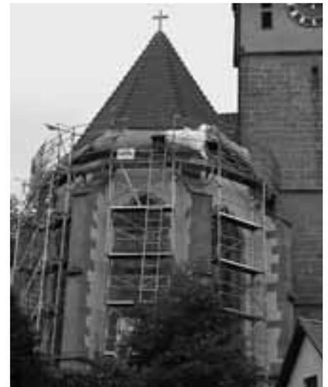
Einzelne Balken sind abgefällt, andere brüchig. Zum Großteil ist das Gebälk 500 Jahre alt. Deshalb werden auch wieder gut gelagerte Eichenbalken eingesetzt. Die Schäden sind durch eingedrungene Feuchtigkeit entstanden, die nicht abtrocknen konnte.
