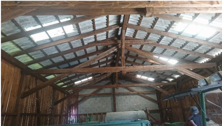
Abbildung 8 Dachstuhl und nördliche Wand der Scheune.
