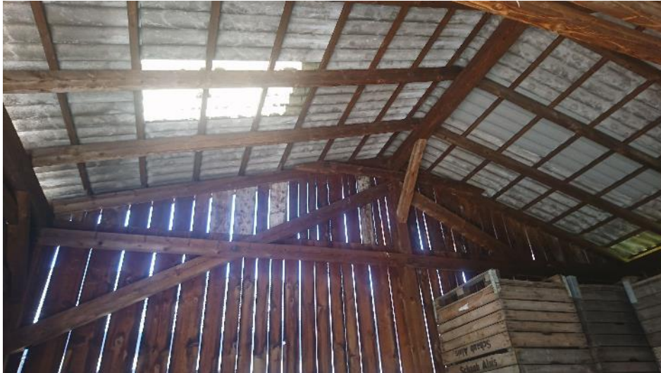
Abbildung 9 Dachstuhl und südliche Wand der Scheune.
