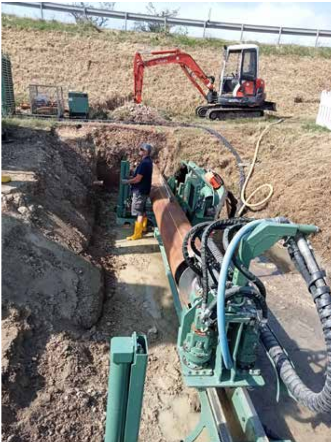
Ein Stahlrohr mit 50 Zentimeter Durchmesser wird durch den Straßendamm gebohrt. Die sechs Meter Stangen werden vor Ort zusammen geschweißt.
