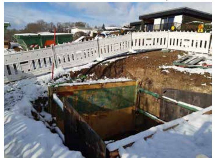
Rohrvortrieb für RW-Entlastungsleitung „Borenbrunnen Nord“.
