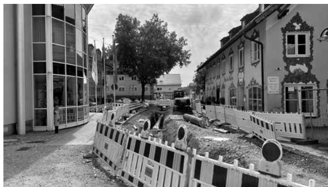
Versorgungsleitungen für die Fernwärmeversorgung in der Hauptstraße
